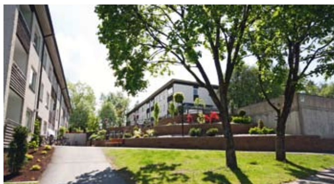
Kv. Giggen har fått en rejäl ansiktslyftning under 2009
